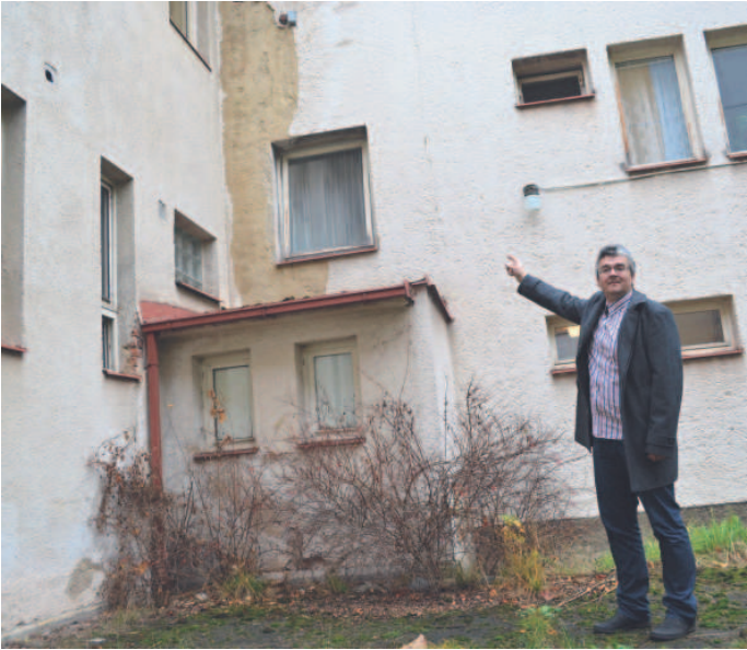
BUDOVA, v níž sídlí oddělení klinické biochemie, je, jak ukazuje technický náměstek ONT Michal Uiberlay, v dezolátním stavu a bude zbourána. Foto: Deník/Vladimíra Odrobiňáková
